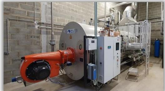
Un nouvel équipement moins polluant car plus intelligent: il calcule en temps réel l'apport d'air nécessaire au bon fonctionnement du brûleur, ce qui permettra de **réduire de 5% la consommation de gaz annuelle.**
